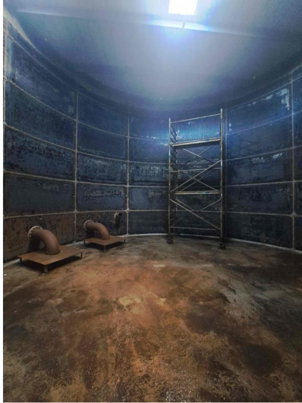
Na reinigen en drogen Zinklaag plaatselijk intact
